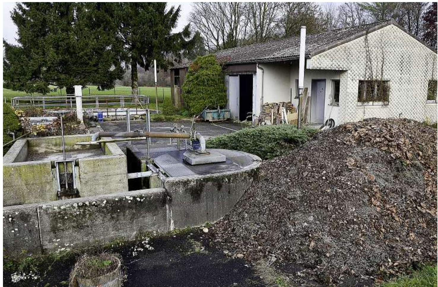
Auf dem Areal der ARA Bannwil entstehen nächstes Jahr ein neues Pumpwerk und ein Regenüberlaufbecken. Die bestehende Anlage wird abgebrochen – mit einer Ausnahme: Das Betriebsgebäude im Hintergrund könnte umgenutzt werden.
