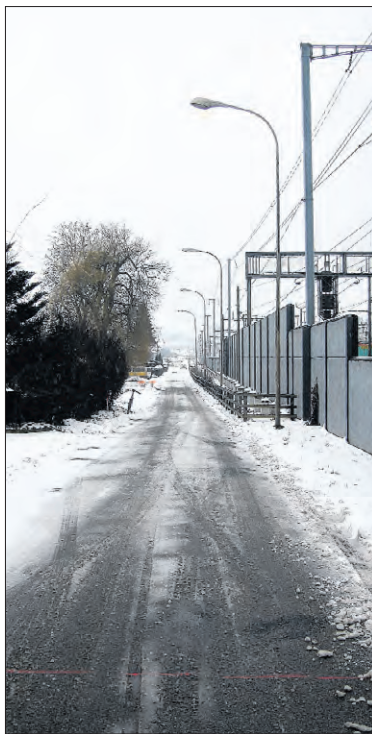
GABISMATT Es stehen umfassende Sanierungen bevor. 16
