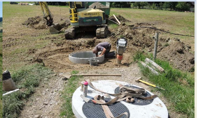
Neubau Abwasserpumpwerk Fraumatt
