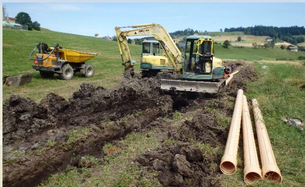
Bauarbeiten im Kulturland (Abwassersammelleitung)
