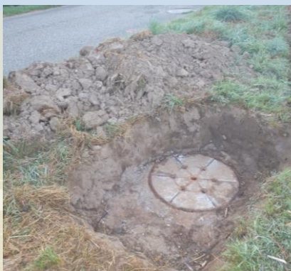
Feldvermessung der Kontrollschächte
