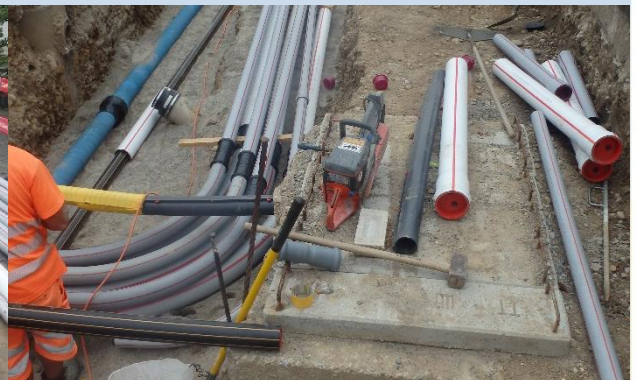
Kabelschutzrohre zur neuen Verteilkabine
