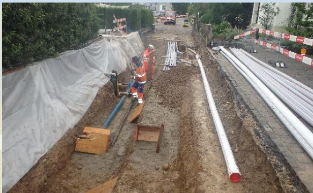
Leitungsbau im Kombigraben
