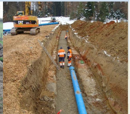
Leitungsneubau Anschluss Lotzwil (Kulturland)
