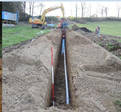
Leitungsneubau Anschluss Langenthal (Kulturland)
