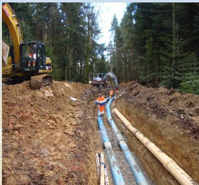
Leitungsneubau Waldweg Druckwasser/Entleerung
