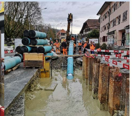
Rohreinzug ab Baugrube Melchnastrasse
