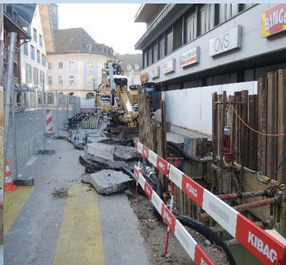
Baugrubendispo Spülbohrung St. Urbanstrasse
