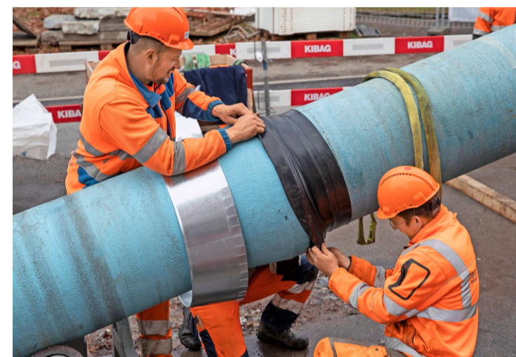
Die Bauarbeiter setzen Stück für Stück zusammen.
