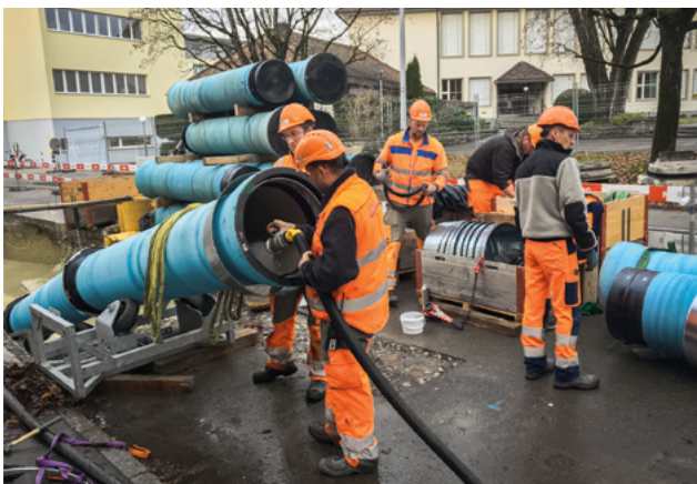
Durch das Füllen der Rohrleitung mit Wasser wurde der Auftriebskraft entgegengewirkt.
