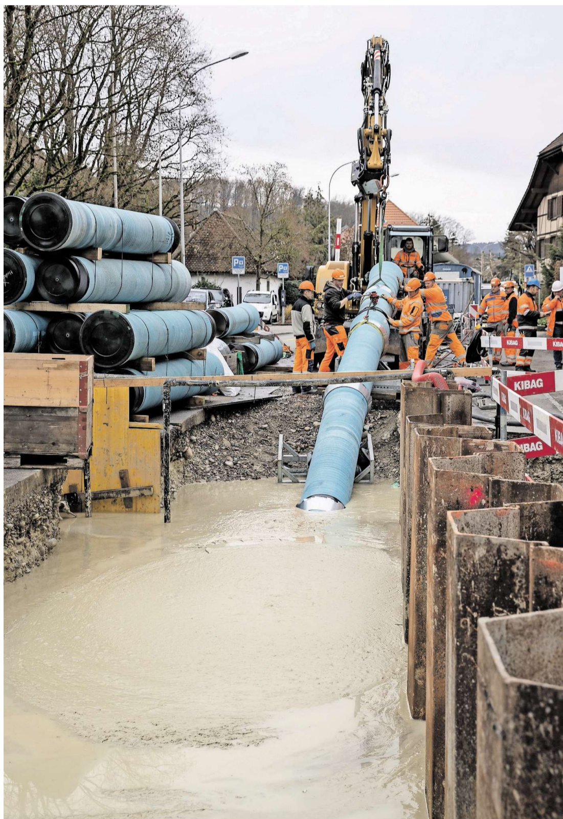
Mit Manneskraft und der Unterstützung eines Krans werden die Gussrohre in den schlammigen Boden gelassen. Fotos: Beat Mathys
