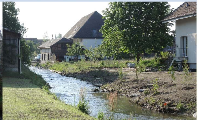
Naturnahe Ufergestaltung nach Instandstellung
