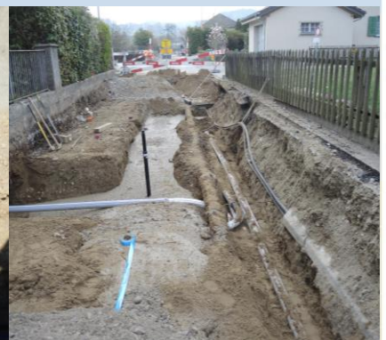
Aufgefüllte Leitungsgräben mit Flüssigboden
