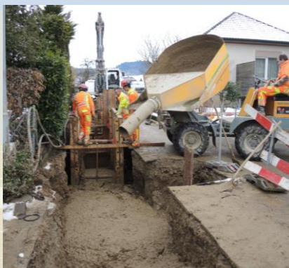
Einbringen von Flüssigboden mit Dumper
