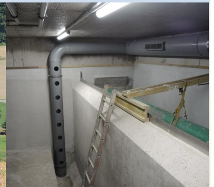
Neue Überfallkante und Lüftung im Becken
